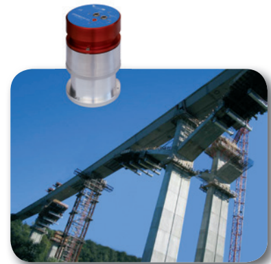
MONITORING OF BRIDGES ÜBERWACHUNG VON BRÜCKEN
